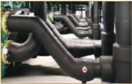
Bảo ôn hệ Chiller Chiller insulation
